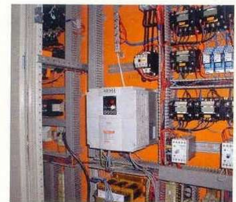
Преобразователь частоты EI-8001 привода подачи щепы
