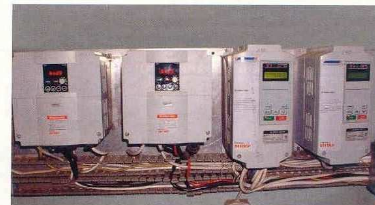
Преобразователи частоты EI-8001 и EI-7011 приводов подачи осмоленной стружки
