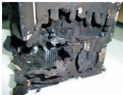
Рис. 1. Повреждение кристаллов IGBT [ 12 ] и внешний вид вышедшего из строя преобразователя частоты.
